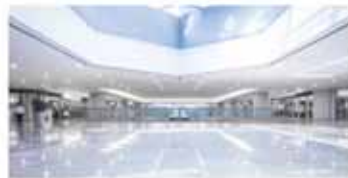
RIPRISTINO PAVIMENTI PROTETTI
